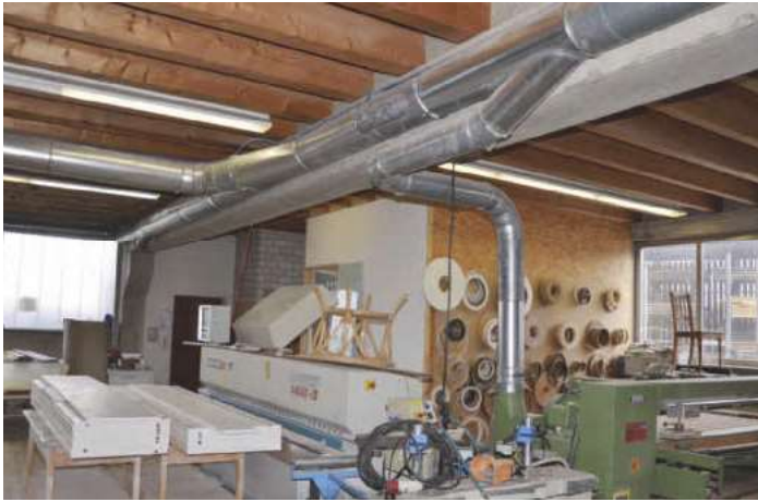
/ Neue Absauganlage, neue Verrohrung: Als Basis für die Rohrdurchmesser wurden alle Daten der Maschinen, ihr Standort und ihre Maschinenleistungsdaten erfasst.
