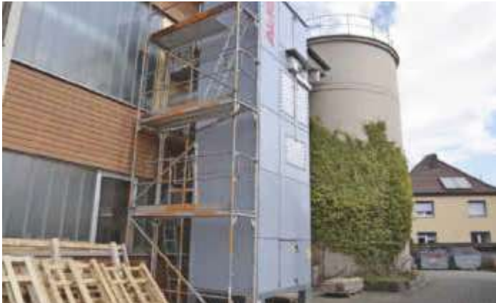
/ Alt und Neu stehen bei Hillmann einträchtig nebeneinander: links Spänebunker, Filterhaus und Rundaustragung, rechts der Silo als Empfänger der Späne.
